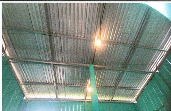
Foto 3: LAMINA TROQUELADA CALIBRE 26 INSTALADA EN EL AULA Y COCINA
