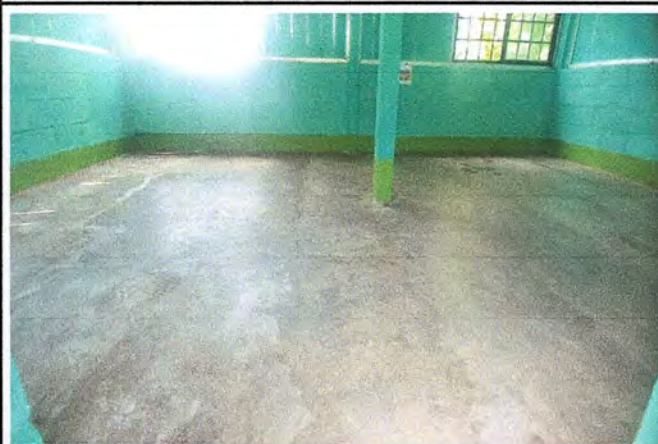
Foto 4: MEJORAMIENTO DE LOSA DE PISO TERMINADA
