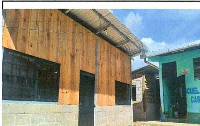
Foto 2: PUERTA METALICA INSTALADA
